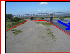
河道掘削(イメージ)
