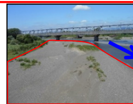
河道掘削(イメージ)
