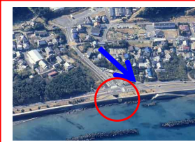
東沢川樋門整備
