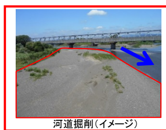
河道掘削(イメージ)
