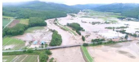
〔空知川における浸水被害(富良野市)〕
