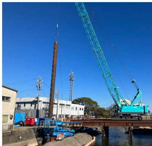
高橋下流左岸側での鋼管矢板打設状況
