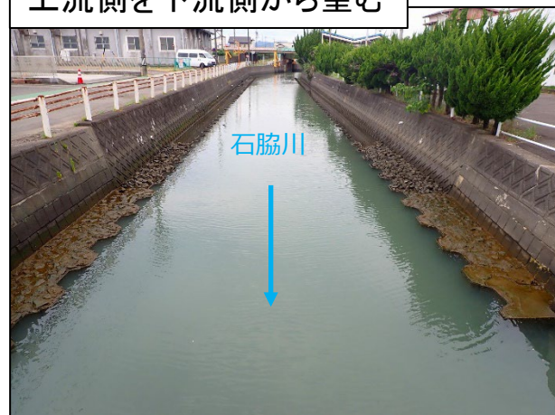
上流側を下流側から望む
