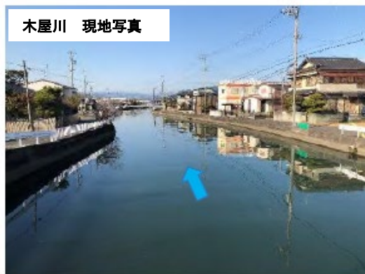
河口から1.0km地点（和田濱橋）より下流を望む
