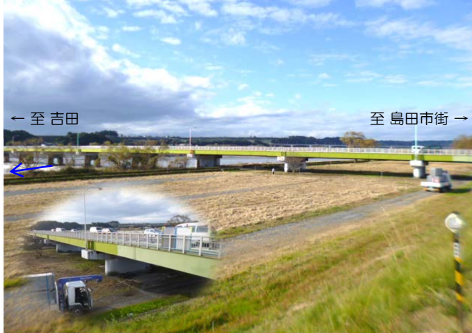
着手前〔平成27年12月 撮影〕
