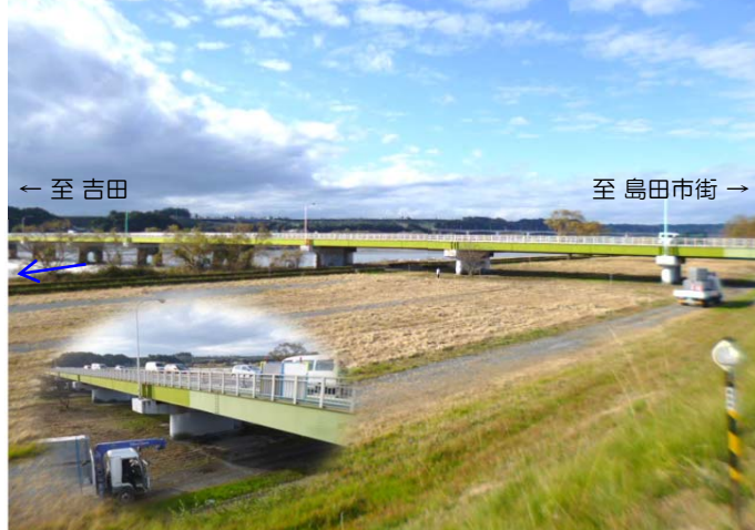
着手前〔平成27年12月 撮影〕
