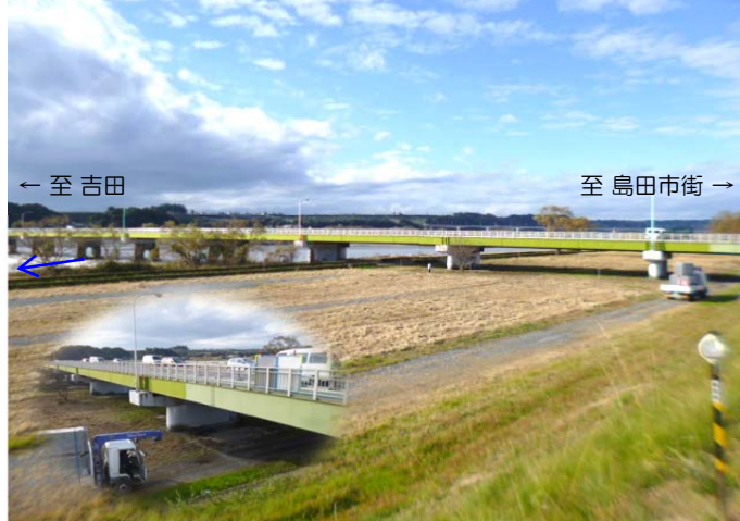
着手前〔平成27年12月 撮影〕
