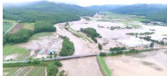
〔空知川における浸水被害(富良野市)〕
