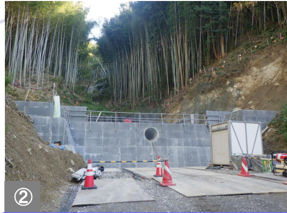
砂防堰堤を整備しています。
