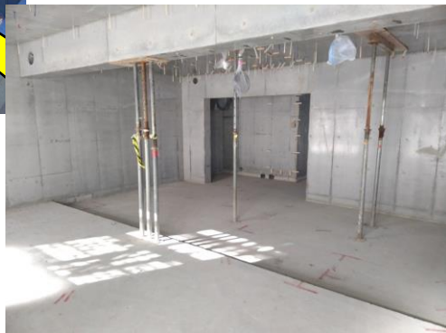
3 階躯体：（R8.1月）
