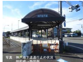
写真 神戸地下道通行止め状況 御前崎一静岡側
