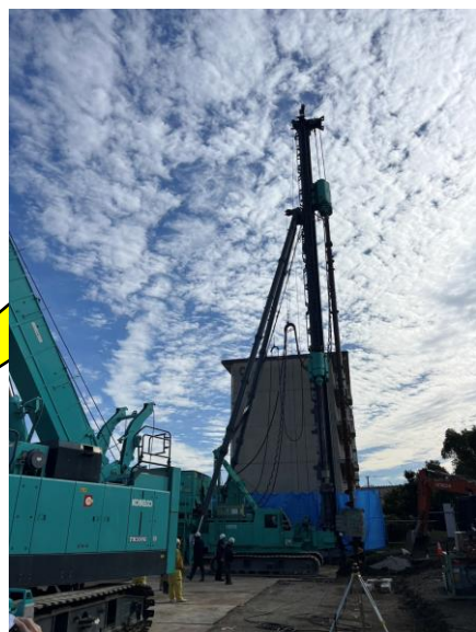
杭打設の様子：（R8.1月）
