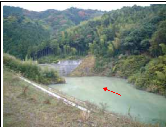
▲洪水調節効果が期待される田代調整池
