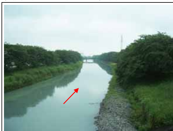
▲下流部は昭和初期の新規開削後、大井川用水の通水路として利用 _桜橋より
