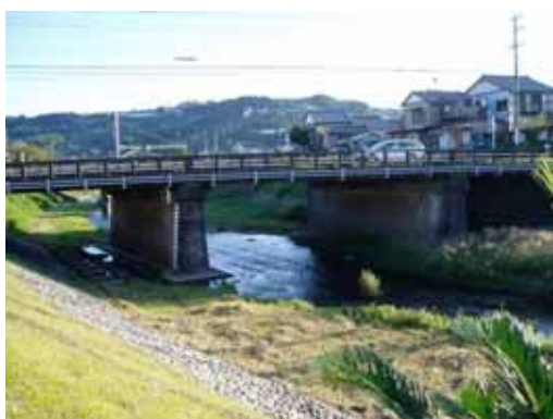
大代川橋水位観測所
