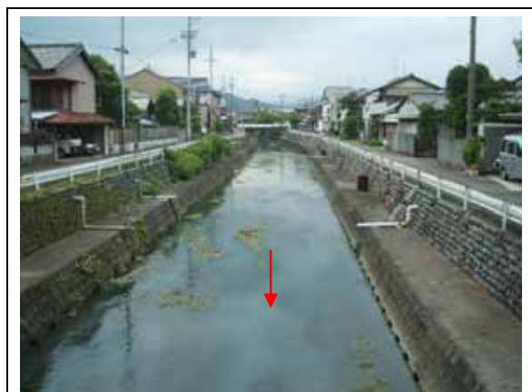
▲ 複断面河道で整備_清見橋より
