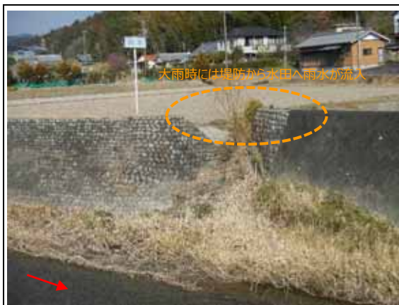
▲堤防の一部が低く、霞堤と同一ような遊水機能を有する箇所
