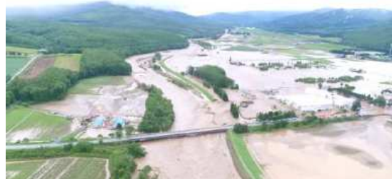
[空知川における浸水被害(富良野市)]
