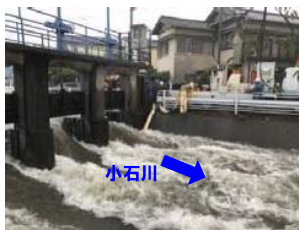
出水時の小石川第7号水門
