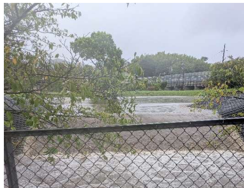
越流堤の改良
