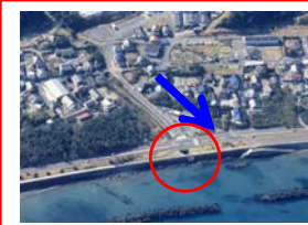
東沢川樋門整備
