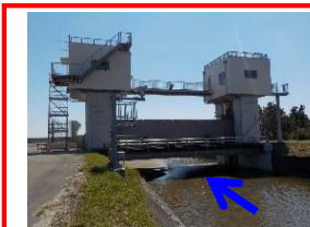
須々木川水門施設修繕
