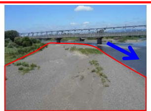
河道掘削(イメージ)
