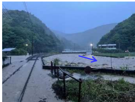
一級河川白光川流域の浸水状況 (島田市高熊)
