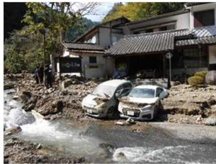
土石流の状況 (静岡市葵区油山)
