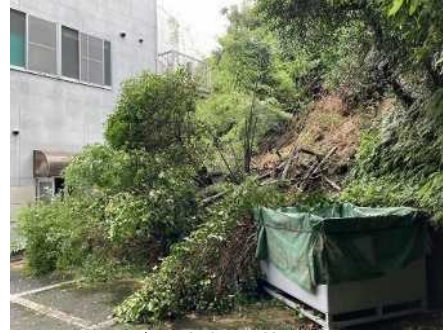
がけ崩れの状況 (湖西市鷺津)
