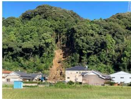
がけ崩れの状況 (磐田市平松)
