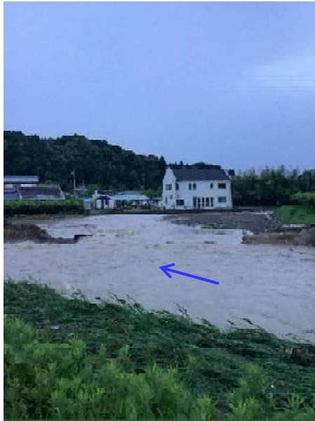
二級河川敷地川の破堤 (磐田市敷地)
