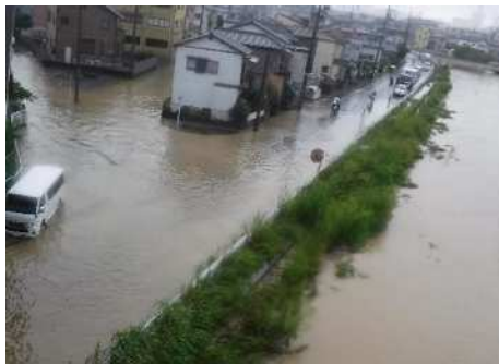
二級河川巴川流域の浸水状況 (静岡市葵区南沼上)
