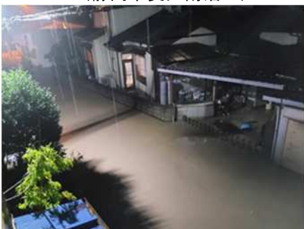
一級河川上野部川流域の浸水状況 (磐田市上野部)
