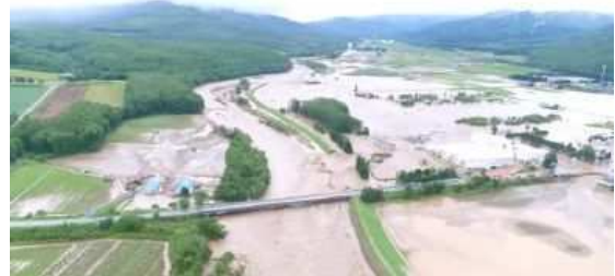
[空知川における浸水被害(富良野市)]
