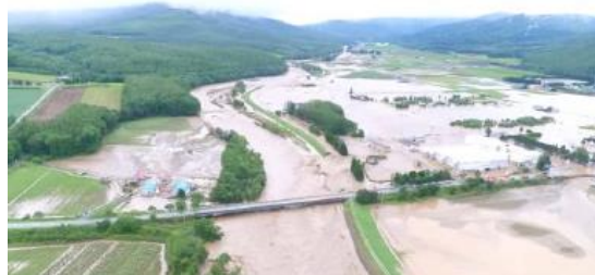
[空知川における浸水被害(富良野市)]
