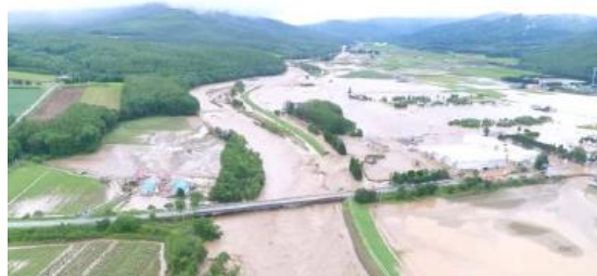
[空知川における浸水被害(富良野市)]
