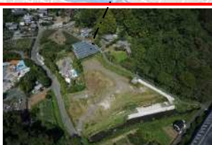
高草川遊水地整備
