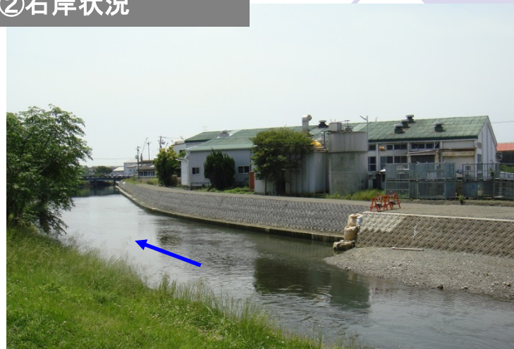
②右岸状況
