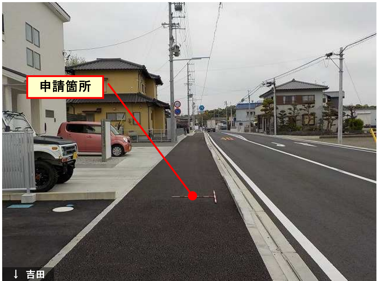
写真-3 起点から終点を望む (近景)
