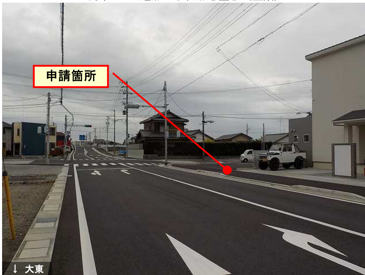
写真-2 終点から起点を望む (全景)
