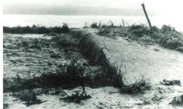
写真 2-3 昭和 57 年 9 月洪水の浸水被害状況
