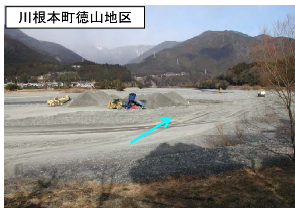
写真 1-8 堆積土砂排除の状況
