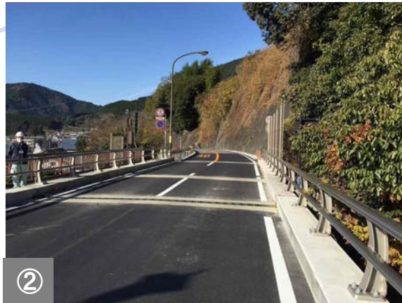
② 完成した跨線部の補強、橋面工の状況です。
