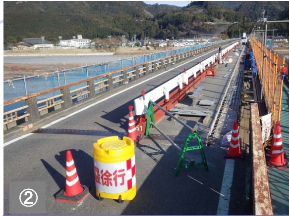
下流側既設床版の撤去に着手した状況です。 (遠景)
