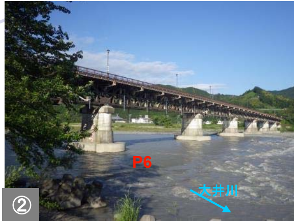
② 完成した渡河部の補強の状況です。
