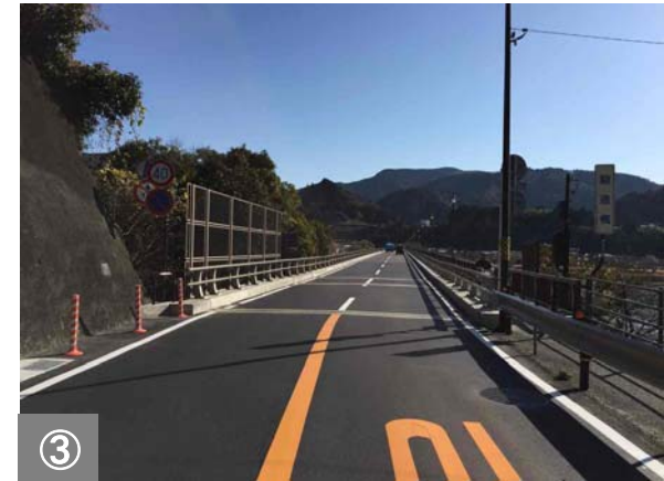
③ 橋梁全長で補強、橋面工が完了しました。
