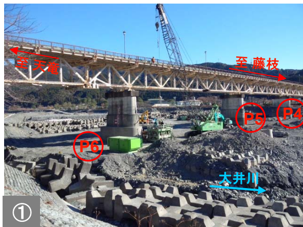
① 橋脚基礎補強工事に着手しました。鋼製の筒を押し込み、直径1.5m、深さ10.0mの穴を掘り、コンクリートを打設して杭を作ります。
