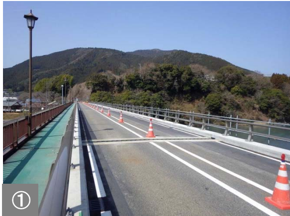
① 上流側、下流側の拡幅が完了した状況です(森町方面)。
