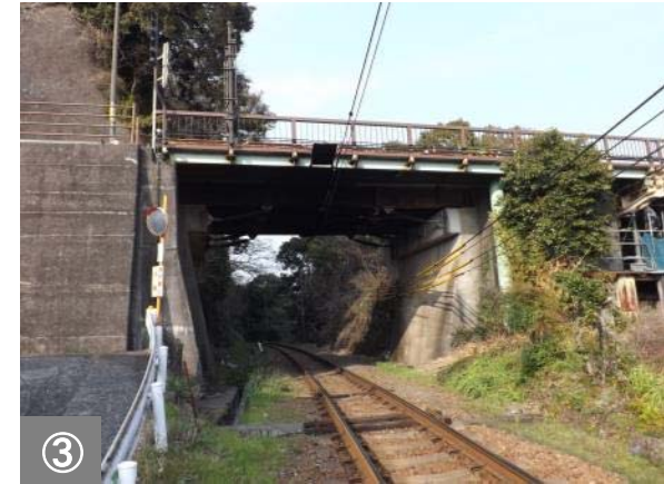
③ 今後、補強を実施していく跨線部です。
