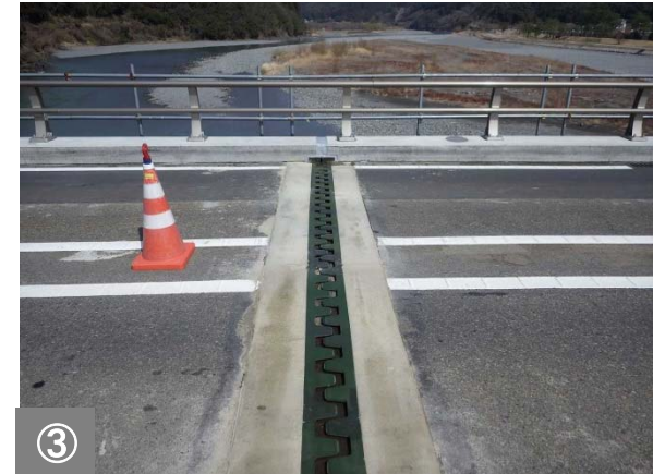
③ 伸縮装置の取替が完了した状況です。
