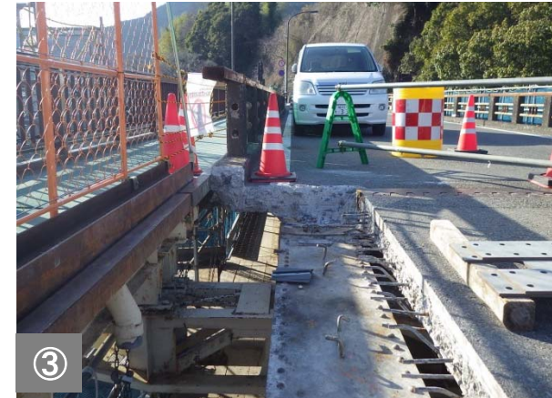
下流側既設床版の撤去に着手した状況です。 (近景)
