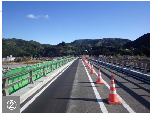
② 上流側の拡幅が完了した状況です(藤枝市方面)。
