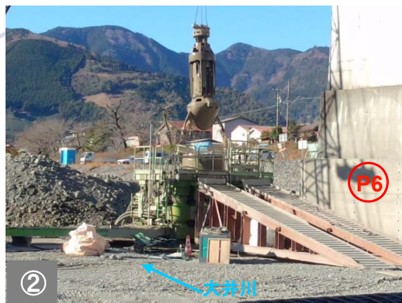
② 杭を設置するために地盤を掘削している状況です。
