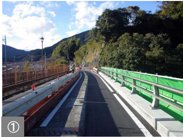
① 上流側の拡幅が完了した状況です(森町方面)。
