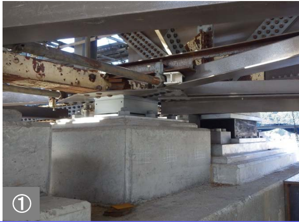
支取替が完了した状況です。
