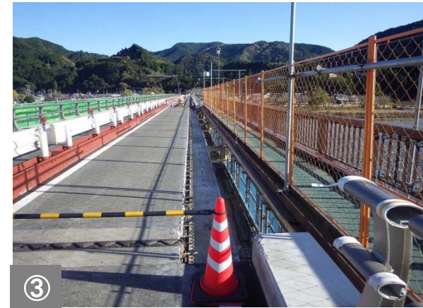
③ 下流側既設床版の撤去状況です。
