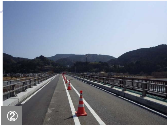
② 上流側、下流側の拡幅が完了した状況です(藤枝市方面)。
