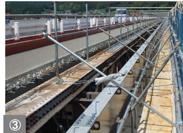
上流側の増桁施工完了状況です。
