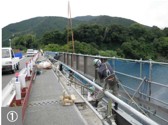
上流側既設床版の撤去後に増桁を取付ている状況です。
