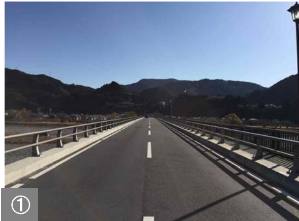
① 完成した渡河部の補強、橋面工の状況です。
