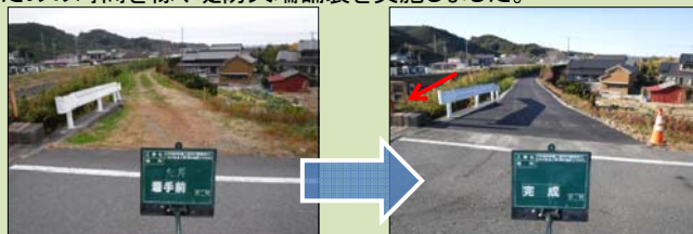
左岸4.3k付近 工事前
