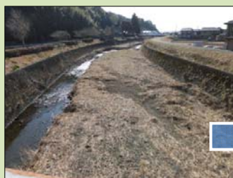
大津谷川河床掘削前
