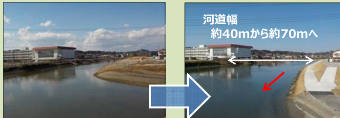
萩間川(0.9k~1.2k付近) 工事前
