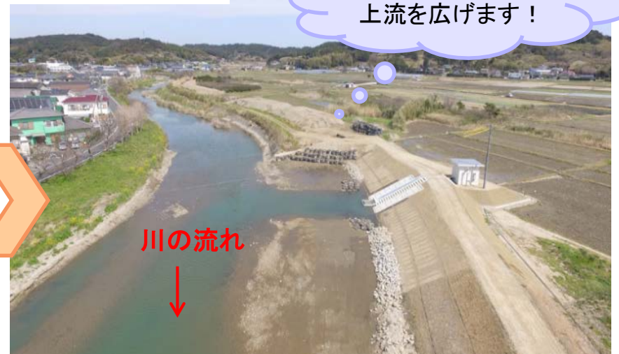
R1年度施工後
