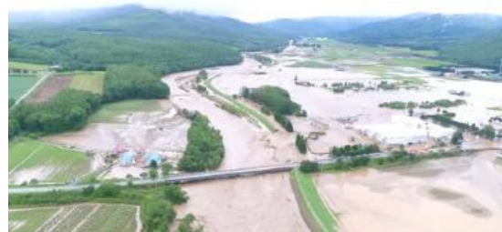
〔空知川における浸水被害(富良野市)〕
