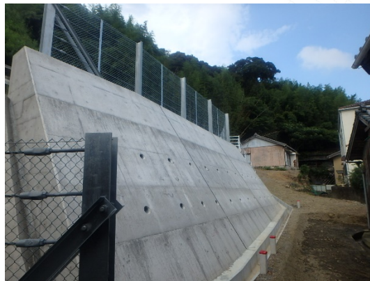
H30完成写真(擁壁工)
