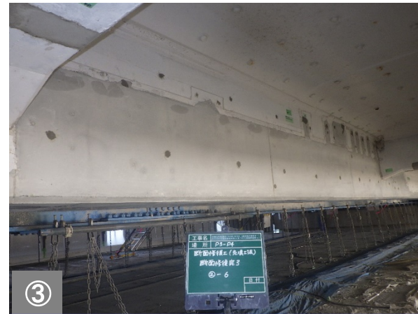
③ 劣化した上部工断面の補修を行います。
