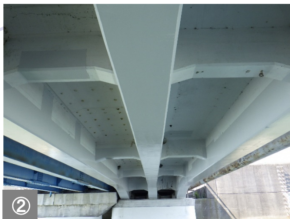
② 劣化した上部工断面の補修を行います。
