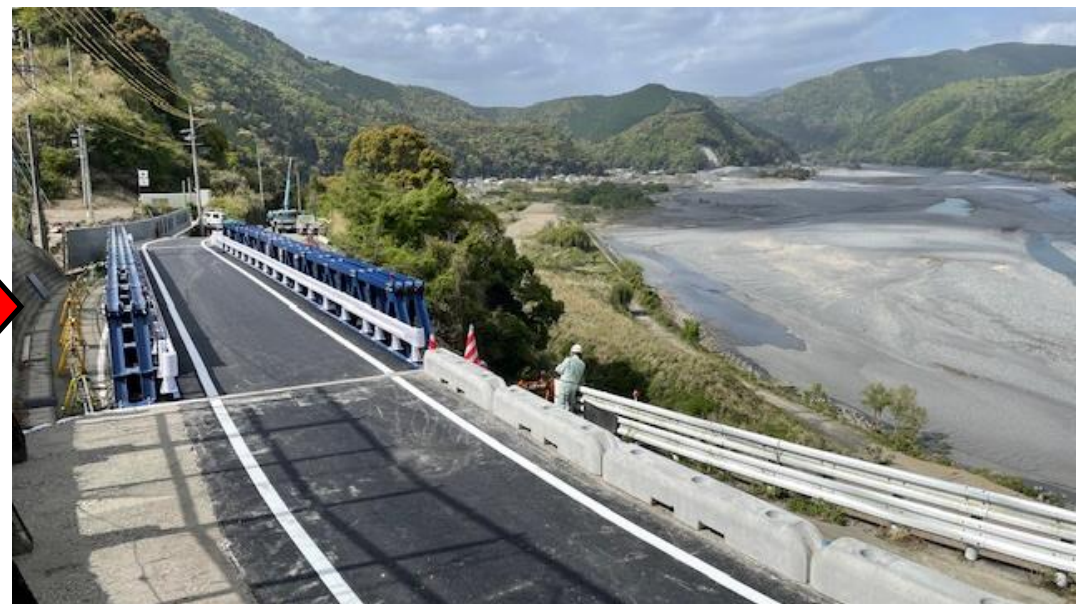
仮設道路設置後
