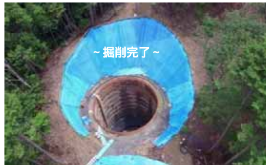
« 3号橋 P5 橋脚_柱状体深礎基礎 11m L=21m »
